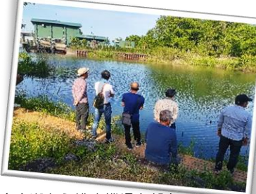
中島内湖から排水機場を望む
